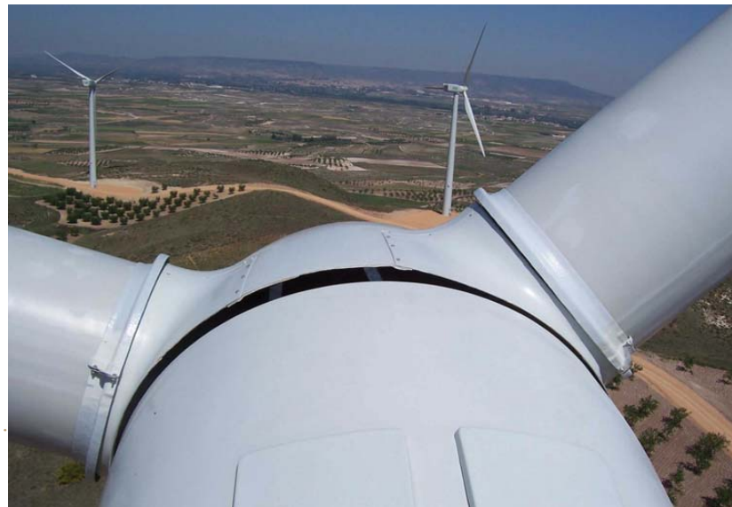
Fotografía 2-1. Parque eólico de 44,8 MW (Alberite de San Juan, Zaragoza)
