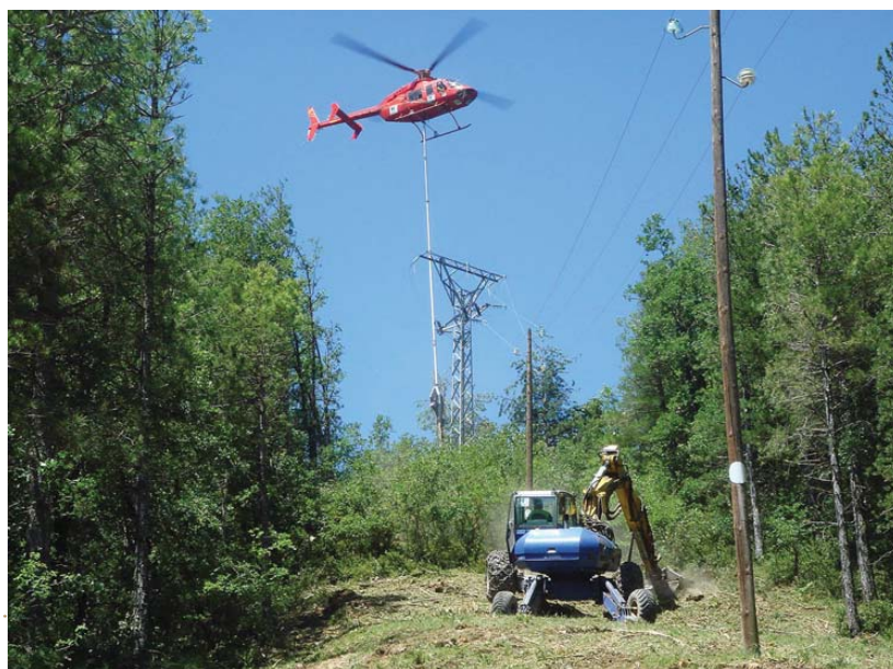
Fotografía 13.2-1. Mantenimiento de líneas eléctricas
