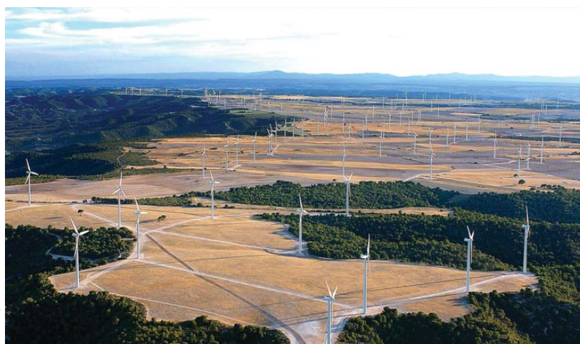
Fotografía 5.2-2. Energía eólica La Plana (Zaragoza)
