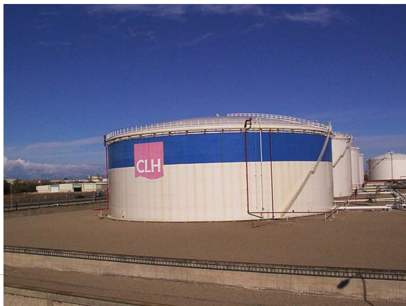
Fotografía 6.4-3. Compañía Logística de Hidrocarburos (Zaragoza)
