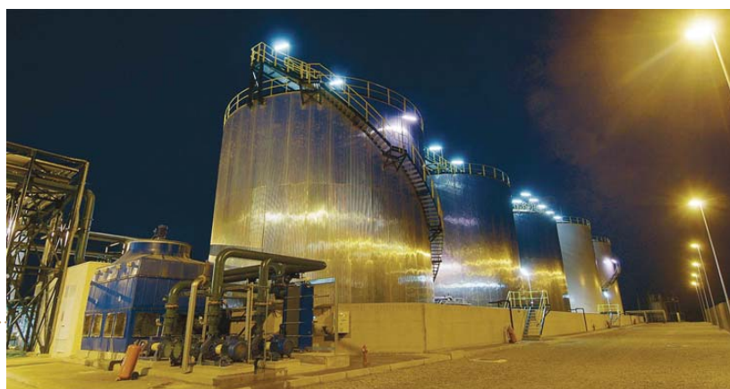
Fotografía 7.2-3. Planta de producción de biodiesel (Altorricón, Huesca)
