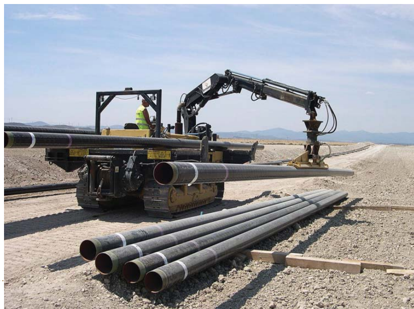
Fotografía 10.3-3. Construcción del gasoducto a Borja
