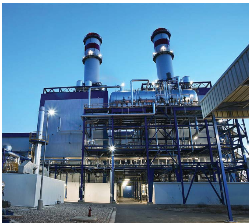
Fotografía 5.2-4. Central de ciclo combinado de 790MW (Castelnou, Teruel)
