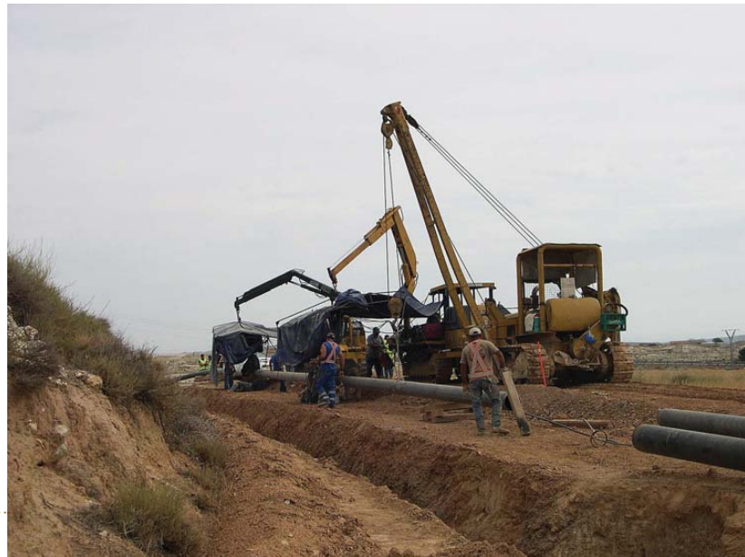
Fotografía 10.3-2. Construcción del gasoducto a Belchite
