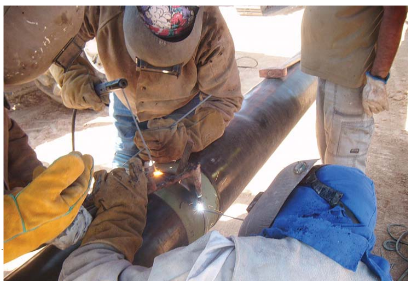
Fotografía 13.3-2. Construcción del gasoducto a Caspe
